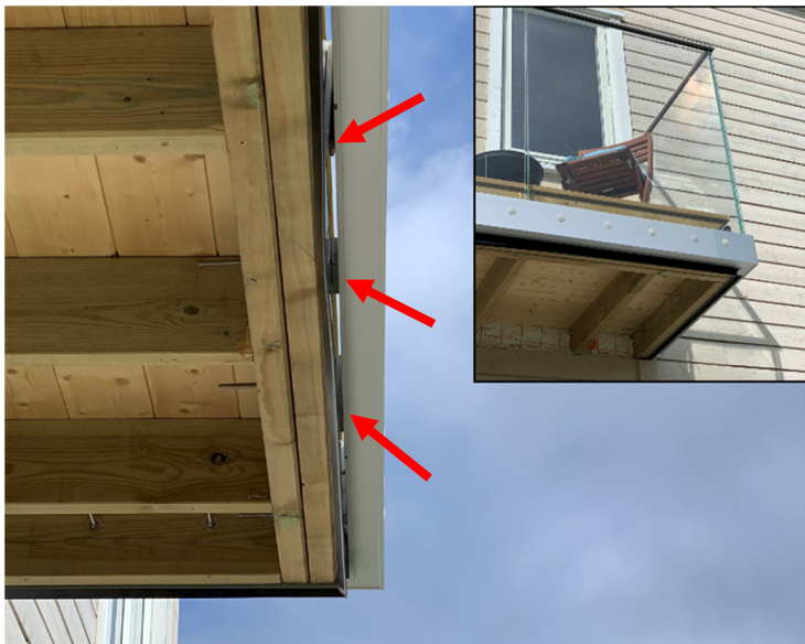
Figur 16 Eksempel på forkantmontert, selvbærende glassrekkverk. Her er det benyttet mellomleggsplater av aluminium mellom bunnprofilet og forkantbjelken, indikert med røde piler. De øvrige konstruksjonsdetaljene er ikke representative for anbefalingene i denne rapporten. Foto: SINTEF
