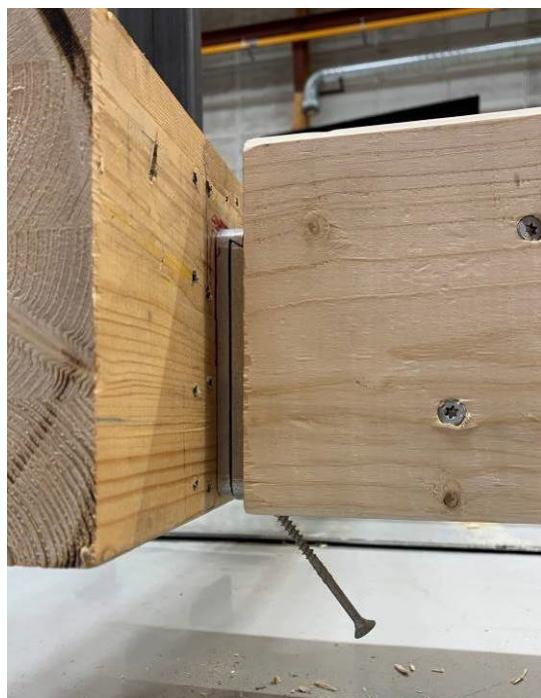
Figur 59 Låsing av beslag med stikkskrue fra undersiden
